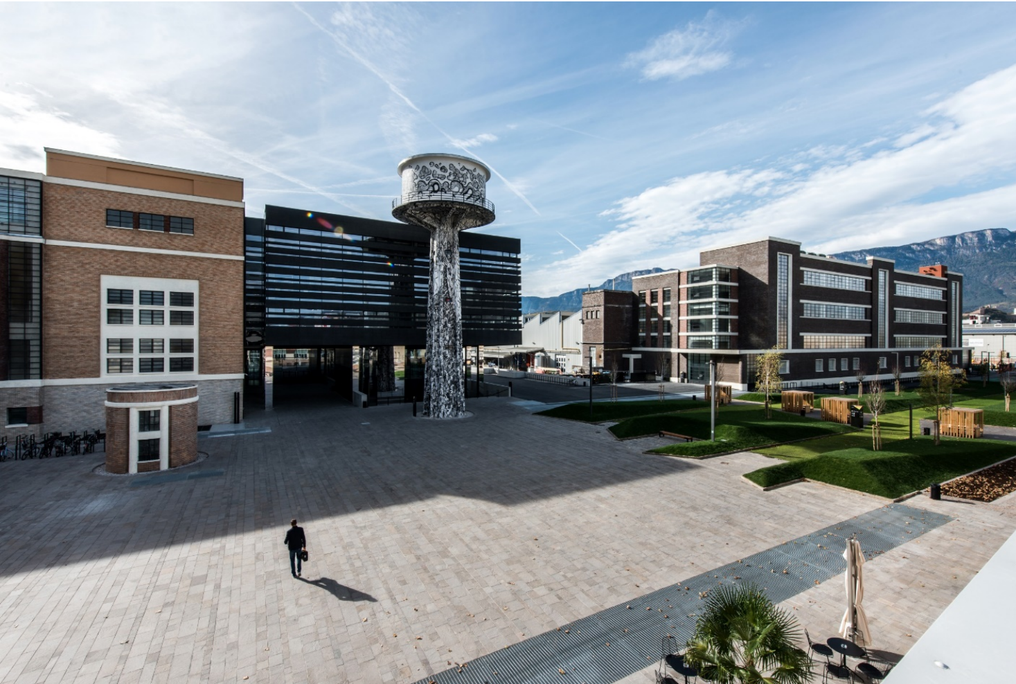
NOI TechPark Bolzano. Credits: NOI spa
