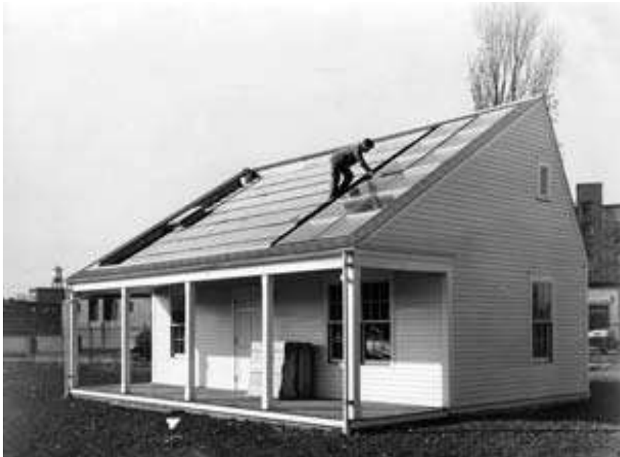
MIT Solar House I, 1939 (direttore di ricerca H.C. Hottel) First solar Thermal integration into the roof
